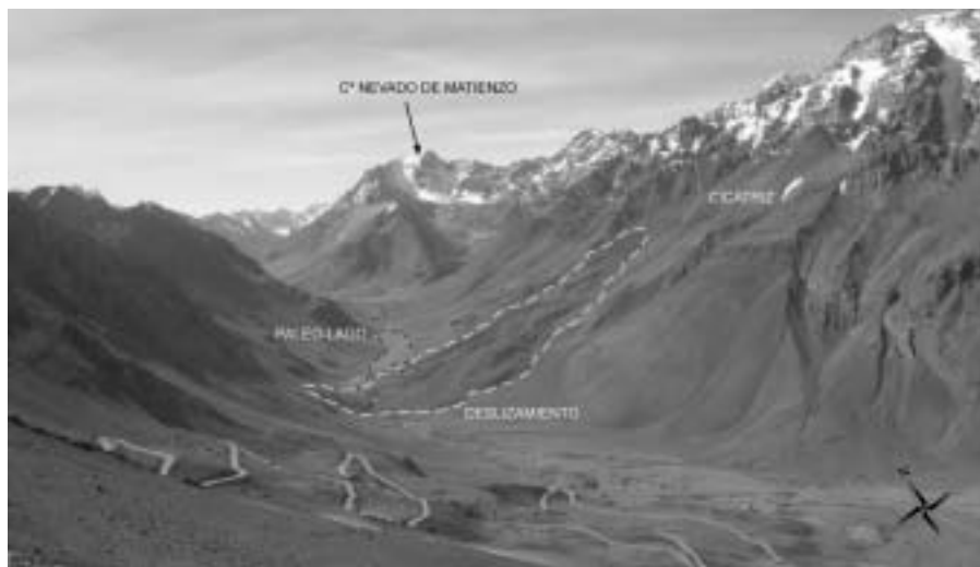
Figura 7: Deslizamiento Matienzo y deslizamiento del Cristo Redentor sobre el cual se construyó el antiguo camino a Chile.
