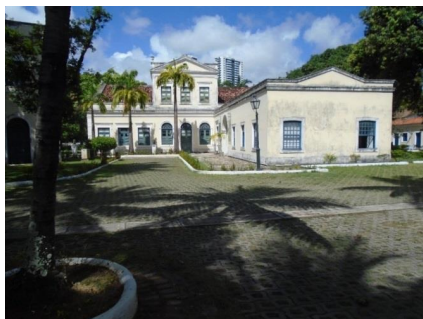
Figura 24 – Prédio da APL, no Recife Pernambuco, Brasil (março/2015)
