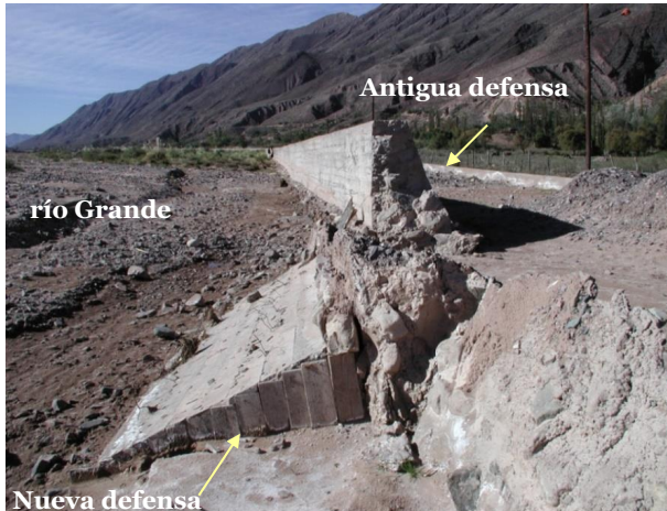
Figura 8. Vista de la nueva defensa y la antigua en el río Grande.
