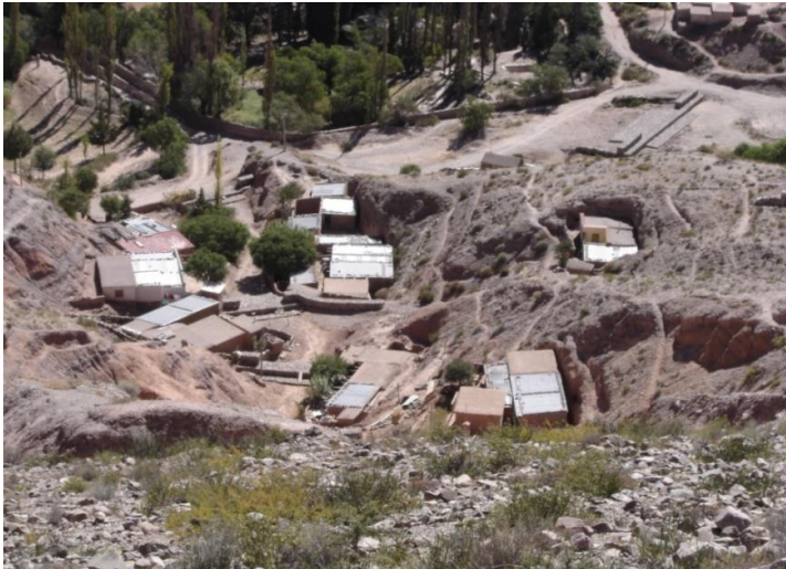
Figura 9. Viviendas emplazadas entre las obras de corrección del torrente.
