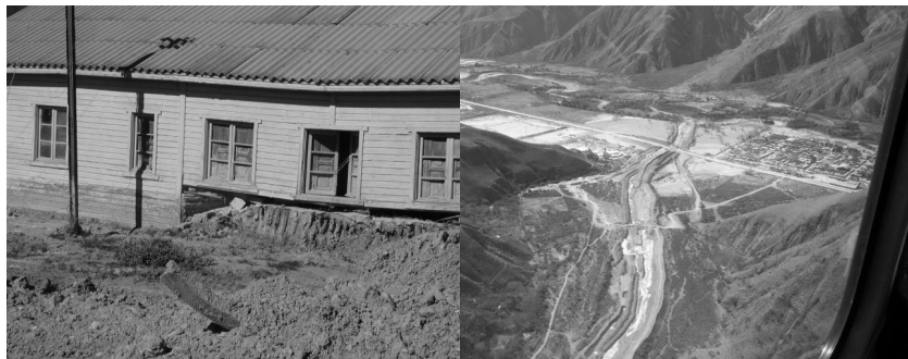
Fig. 2: Vivienda afectada por el flujo denso de enero 2.017 (izquierda).
