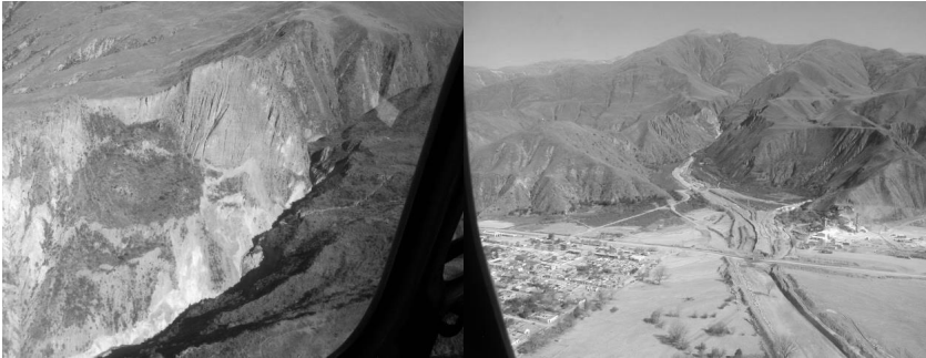
Fig. 4: Deslizamiento traslacional en la quebrada de Los Filtros (derecha).
