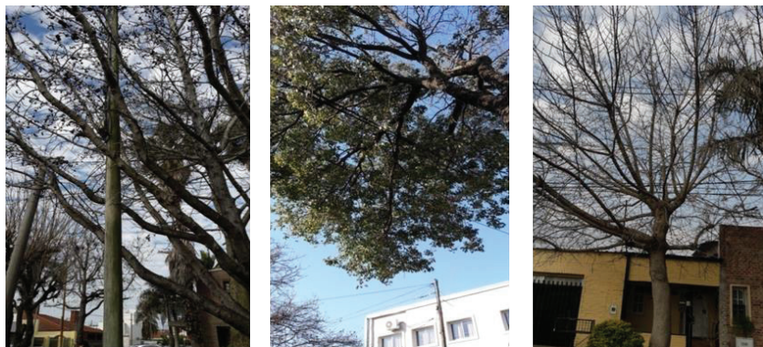
Fig. 8: problemas del arbolado: intersecciones copa/cables en veredas detectados en la Vecinal “Guadalupe Este”. Fuente de datos: archivos digitales y analógicos de la MSF. Colecta a campo realizado en verano del año 2017. Laboratorio de Geografía Física y Ambiental, CONICET, UNL.
