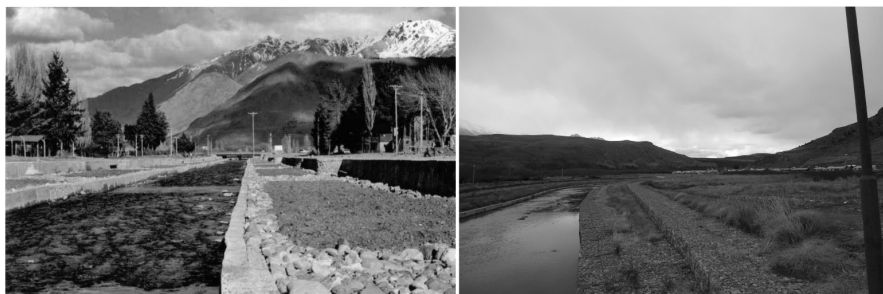
Fig. 2 (izquierda): Corrección de márgenes Tramo II aguas abajo del puente El Trochita (octubre 2007).
