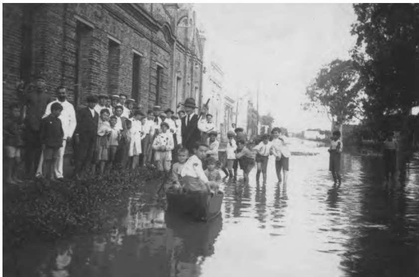
Fig. 1 : Afectación hídrica en la localidad de San Justo
