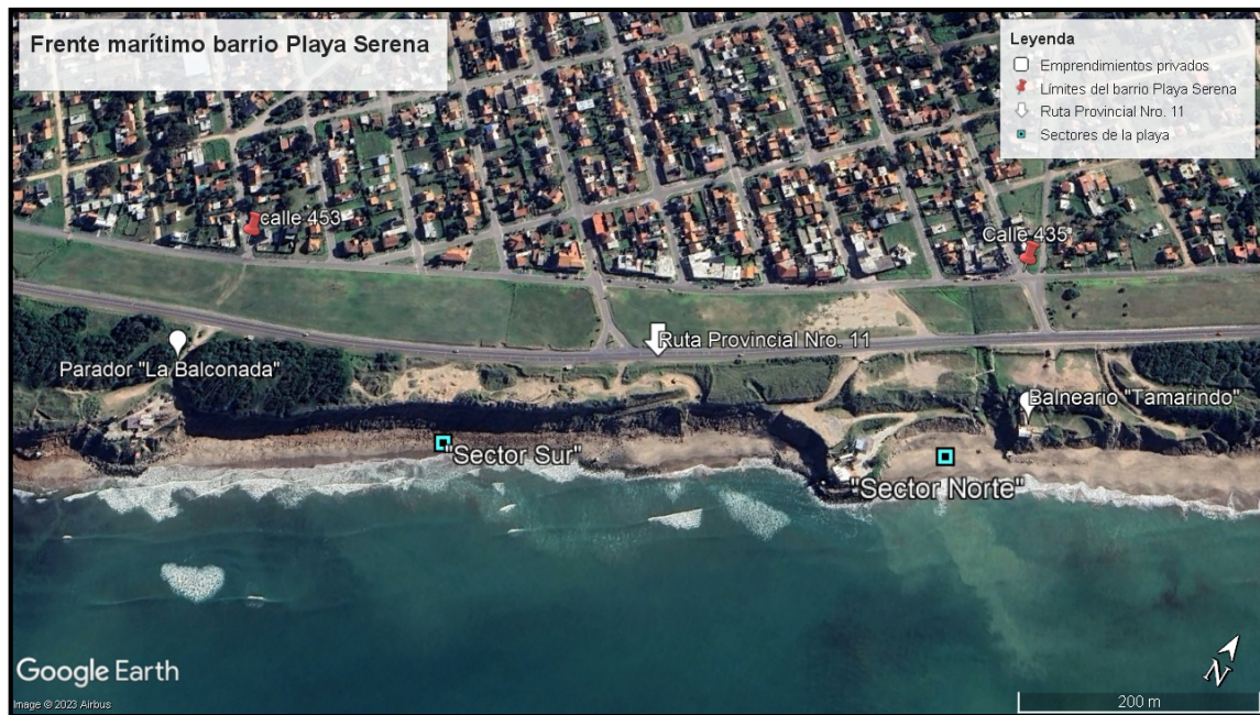
Figura 3: Vista del frente marítimo del barrio Playa Serena
