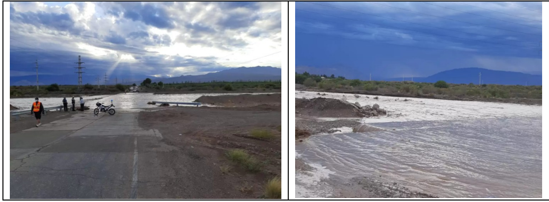
Figura 10: La Ruta 60 quedó obstruida por una fuerte creciente - Valle de Ullum.
