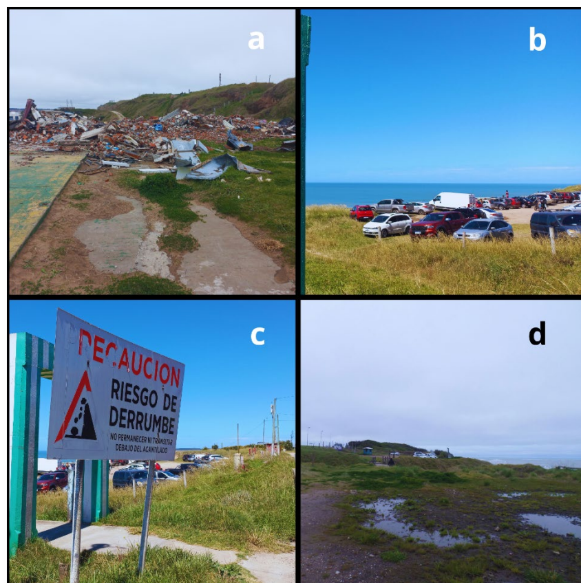
Figura 5: Deterioro ambiental en el frente marítimo de Playa Serena a) Escombros de antiguas edificaciones b) Automóviles estacionados sobre el acantilado c) Cartel de riesgo de derrumbe d) Suelo desnudo consecuencia del tránsito sobre el acantilado
